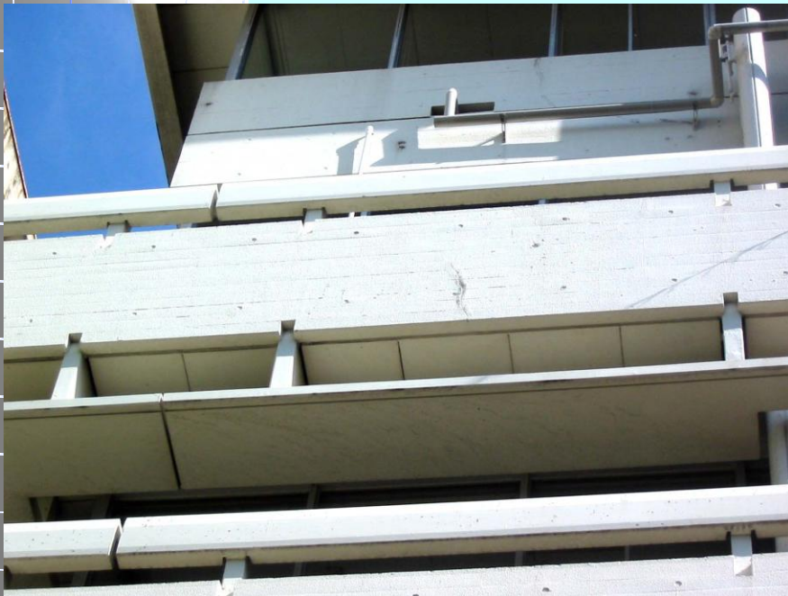
外壁ひび割れ補修跡
